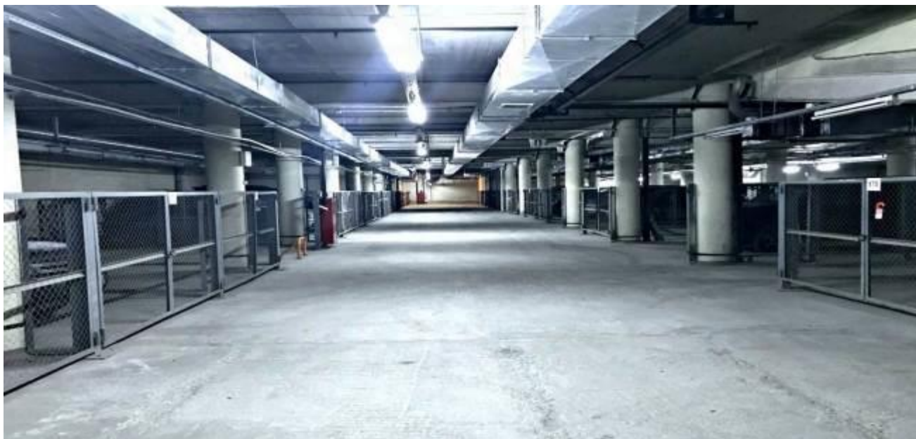
Фото 16-17. Здание паркинга ул. Шейнкмана, д. 73.
